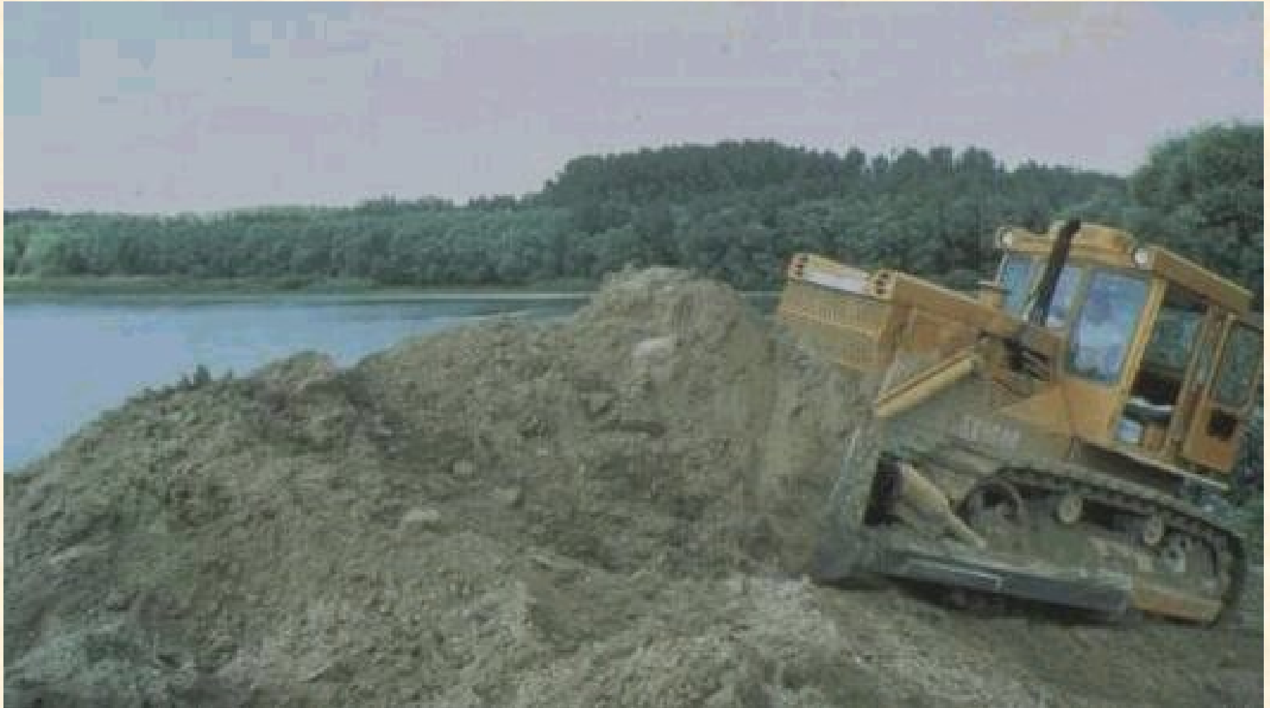
Dam construction on the Danube, Szigetköz, Hungary (Photo: WWF/Hartmut Jungius)
