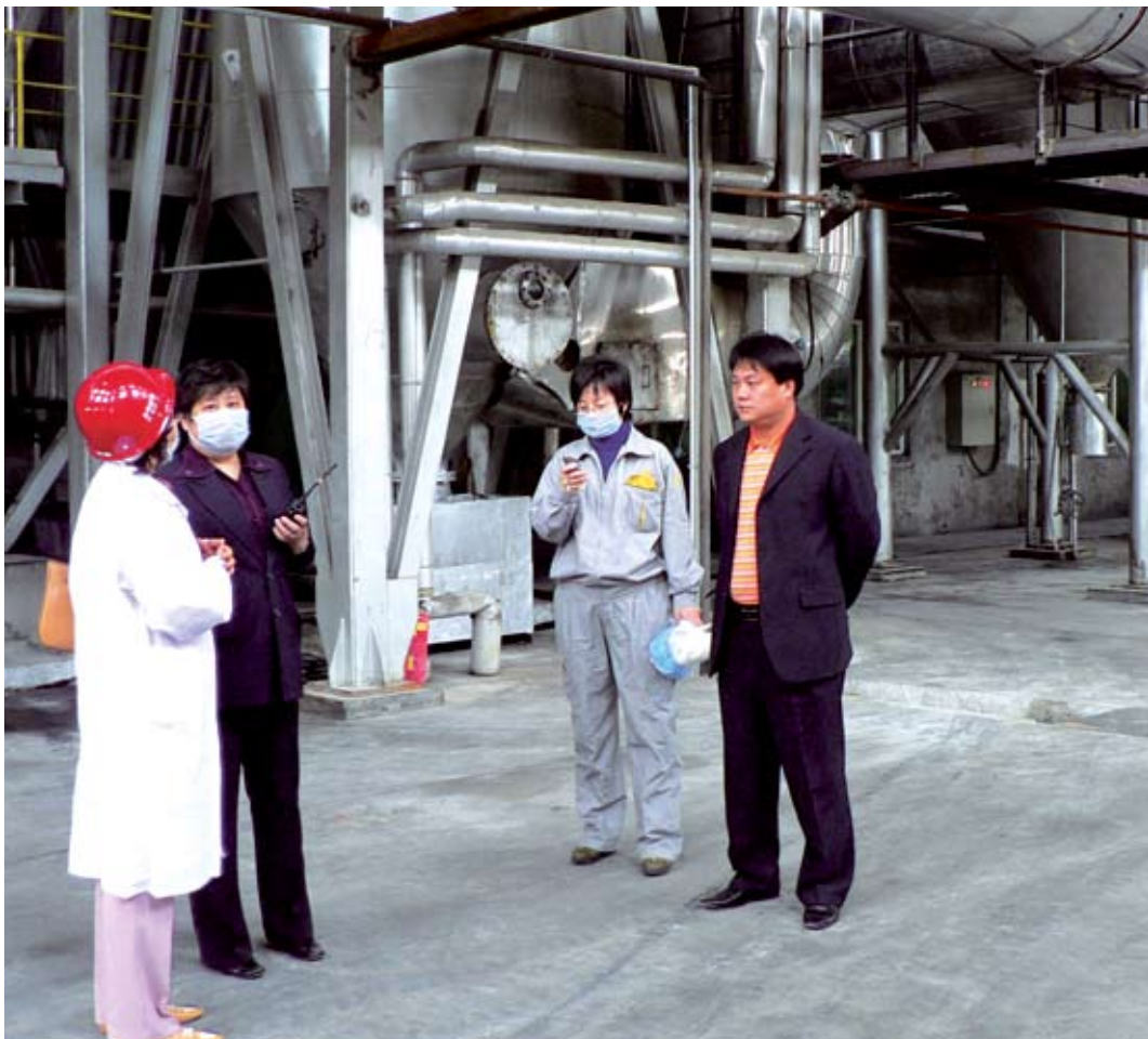
Installation d'incinération des déchetts d'origine médicale Golden State de Beijing
