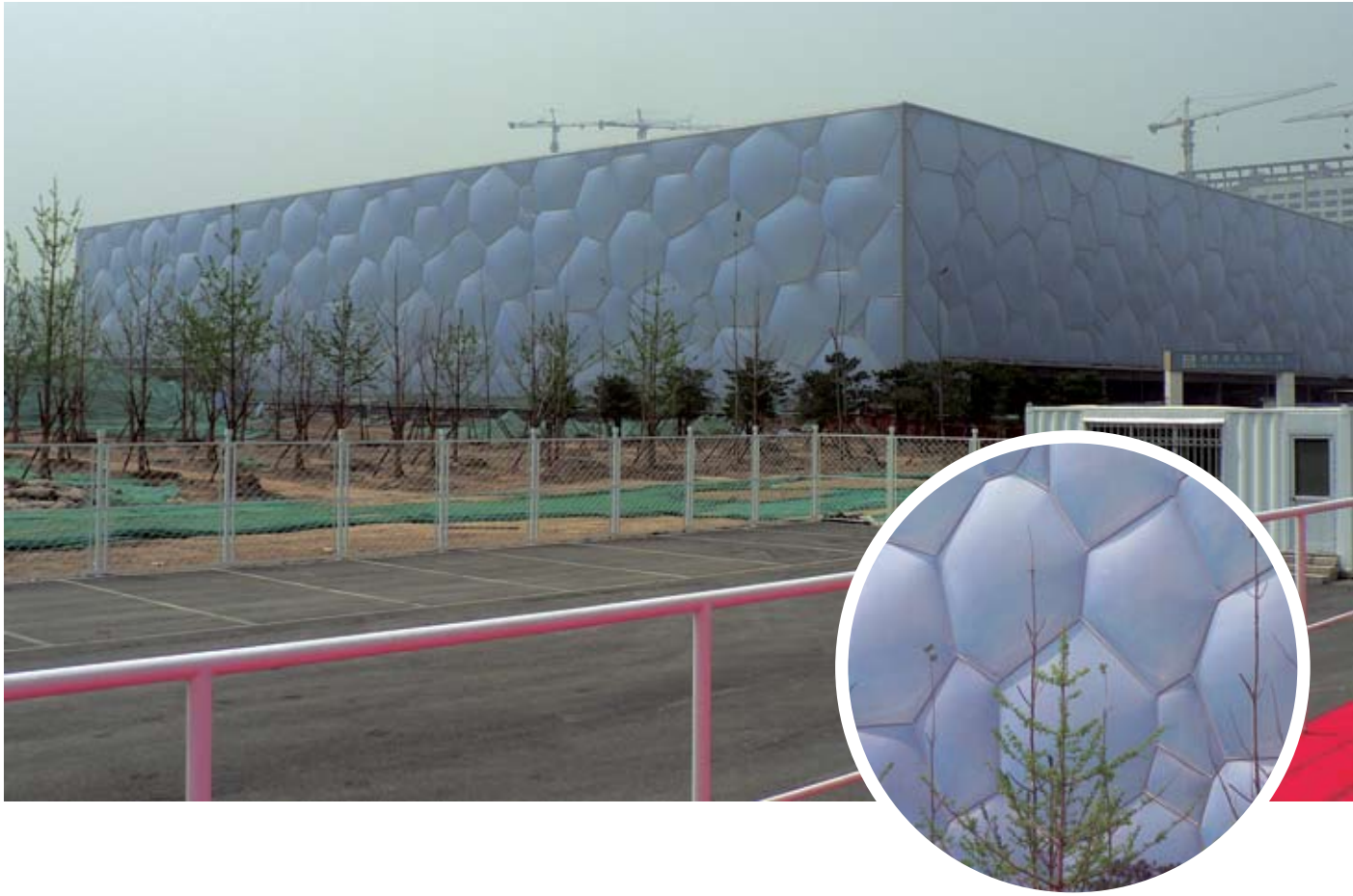
Le chantier de l'Aquacube et un détail de sa membrane translucide
