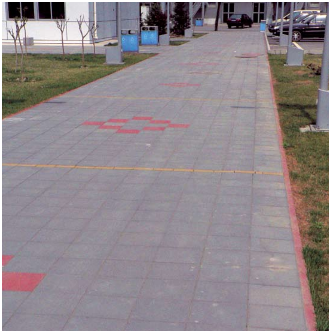
Blocs et parcelles de gazon utilisés dans le pavage du Stade de softball de Fengtai
