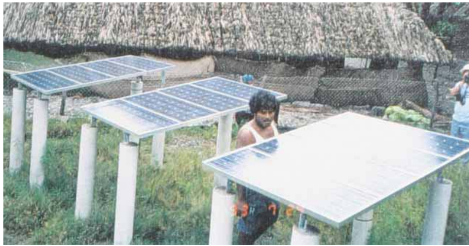
Figure 4-3 - Maneapa panel installation (Kainaba)
