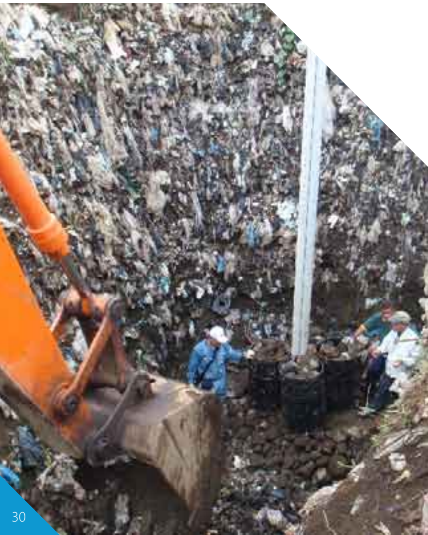
Projet de réhabilitation de la décharge de Tafaigata (Samoa) : Installation de conduites d'aération dans la décharge semi-aérobie
