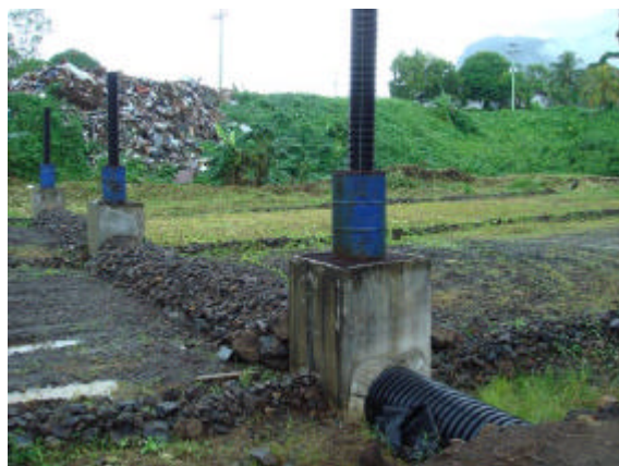
Décharge semi-aérobie « M-dock », aux Palaos
