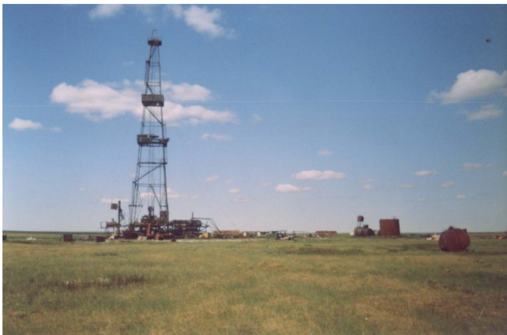
Рис. П.5.3 Зброшенна бурова в районе реки Черная.
