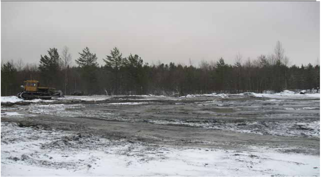
Рис. 3.3.1. Общий вид склада нефтепродуктов (нефтехранилища), расположенного в пос. Покровское Онежского района после завершения планировочных работ.
