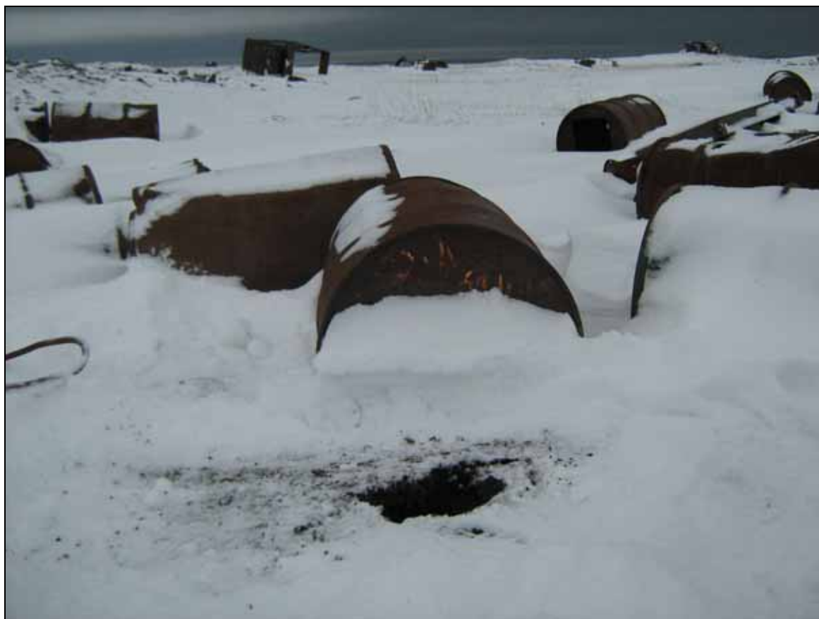
Фото 5.9 Протечка ГСМ с западной стороны здания дизельной станции
