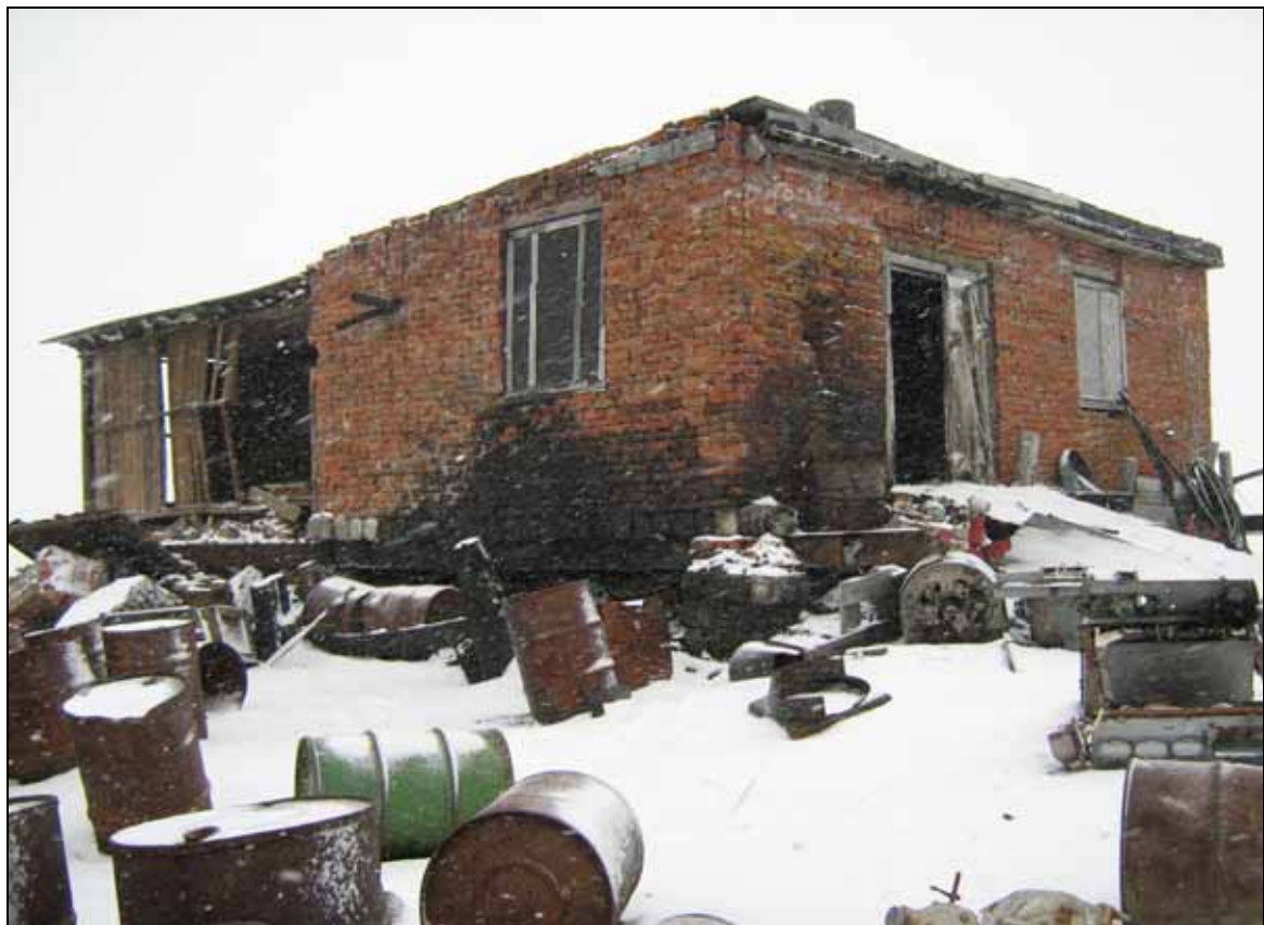
Фото 4.13 Разрушенное здание дизельной станции
