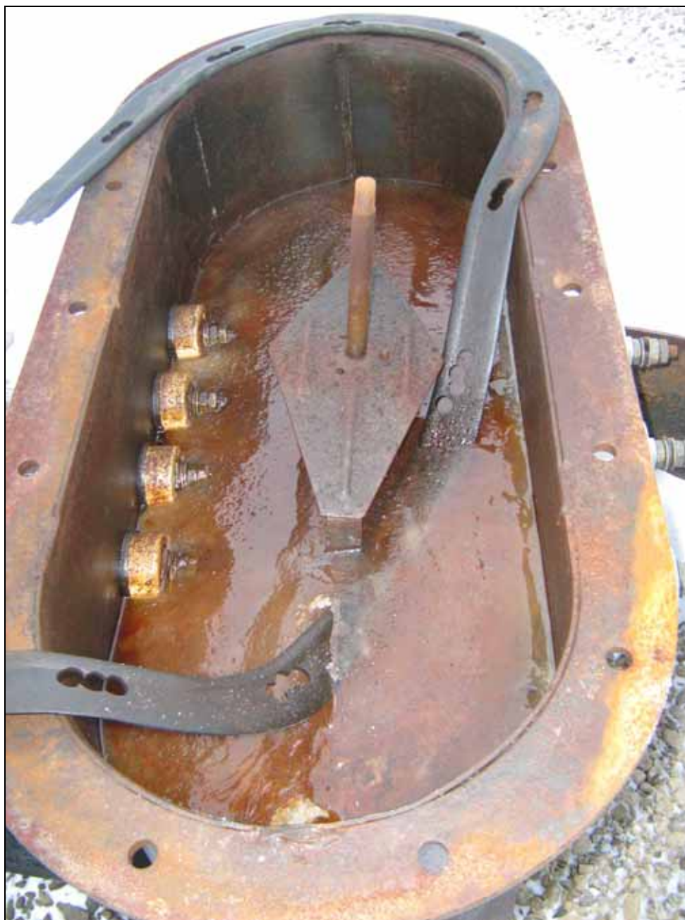
Фото 5.42 Трансформатор (вид сверху)
