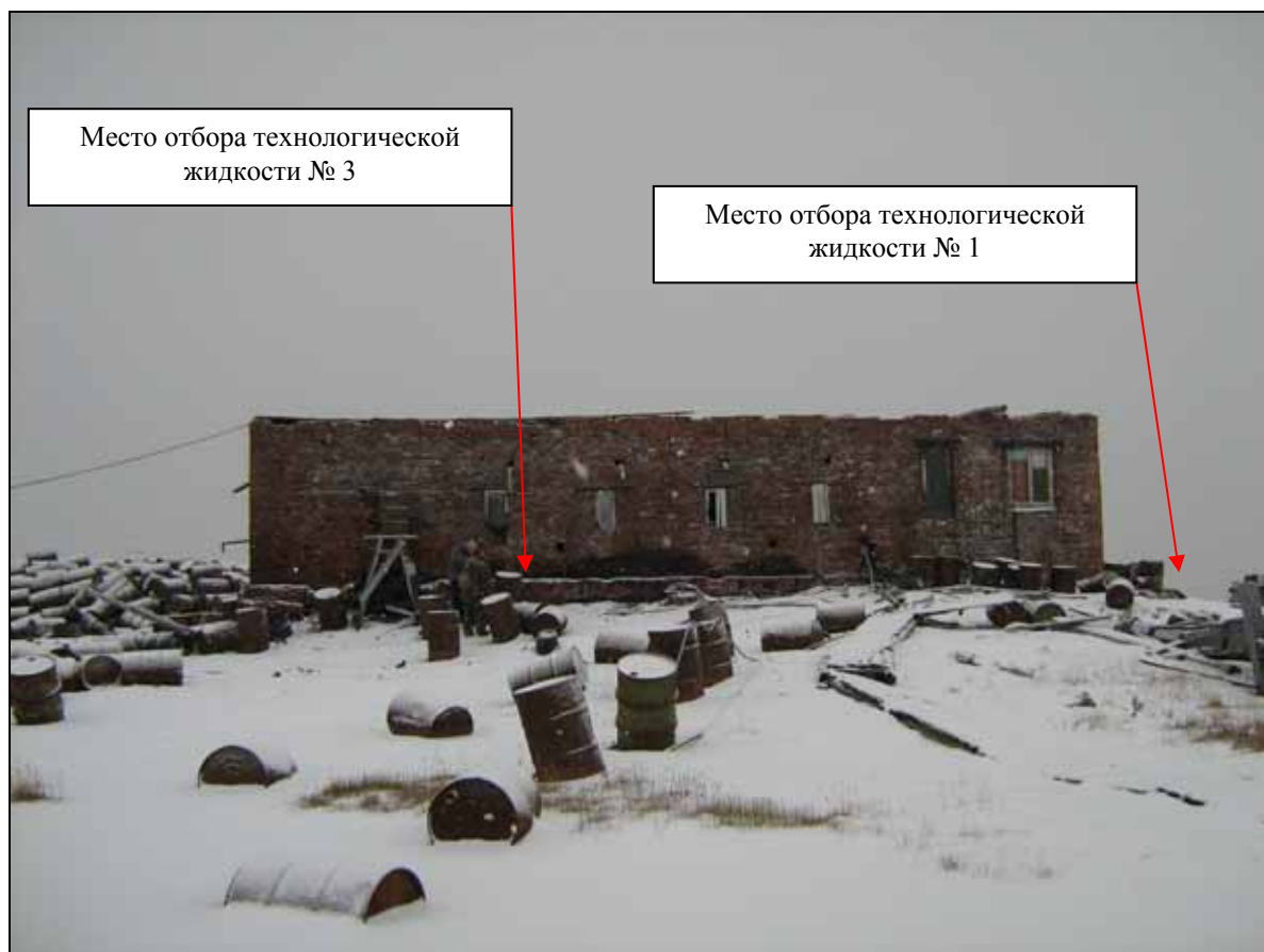
Фото 4.5 Вид на здание дизельной станции с северной стороны
