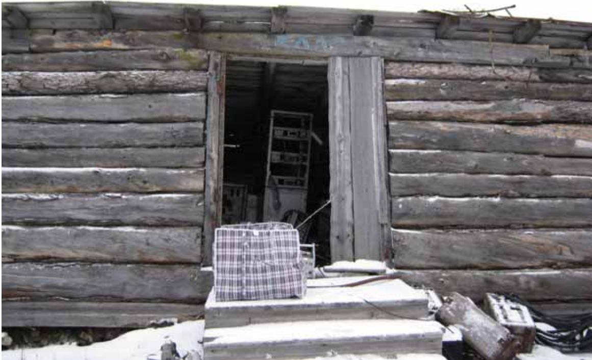
Фото 4.10 Склад с различным оборудованием
