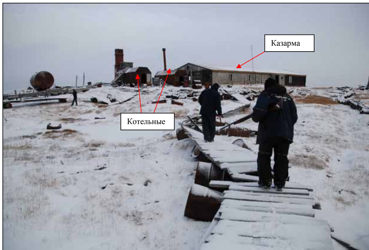
Фото 4.19 Котельная и дизельная станция возле здания казармы
