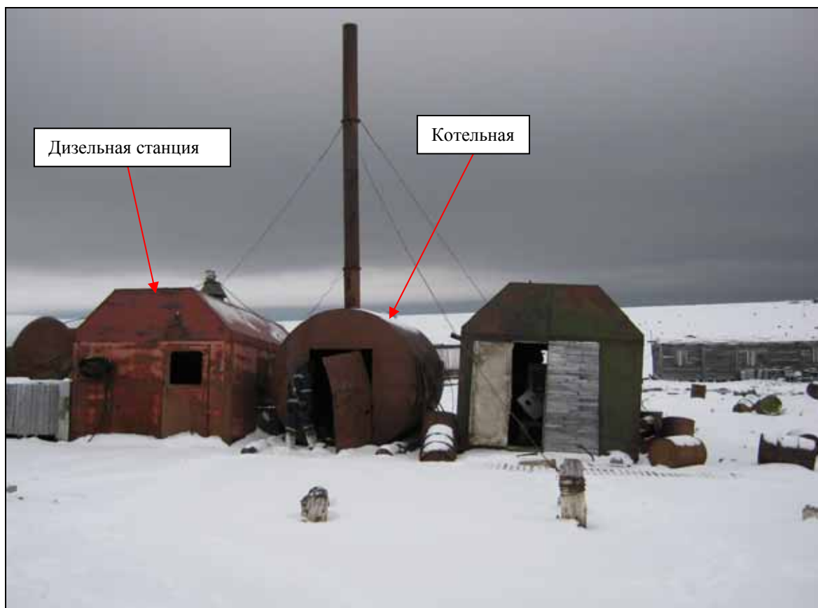
Фото 5.22 Дизельная станция и котельная возле здания казармы
