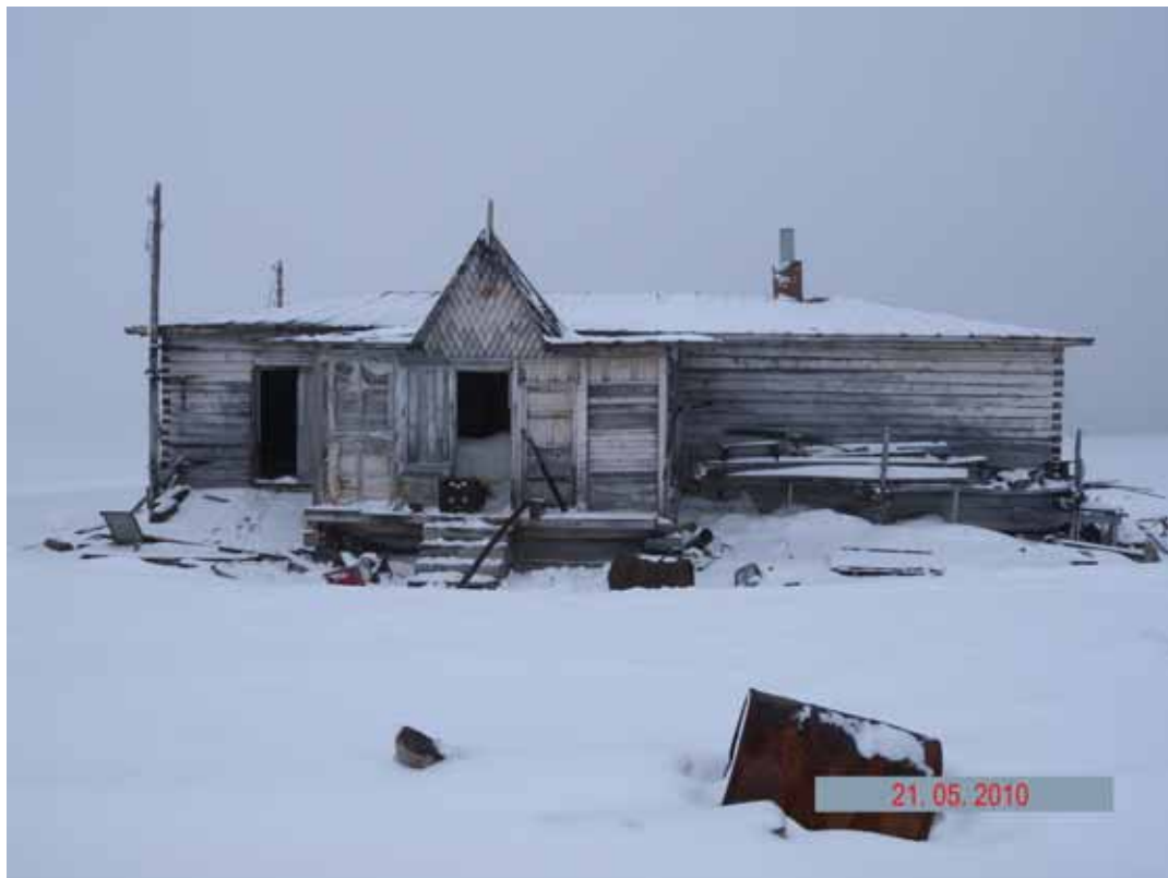
Фото 2.2.19 Здание дизельной (объект № 280) на территории закрытой полярной станции
