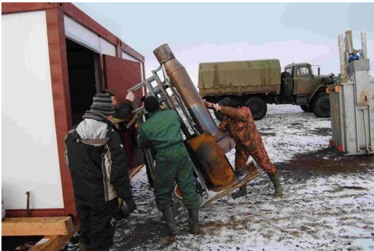
Рис. 13.7. Монтаж установки термического обезвреживания бочек «Факел-1М»;
