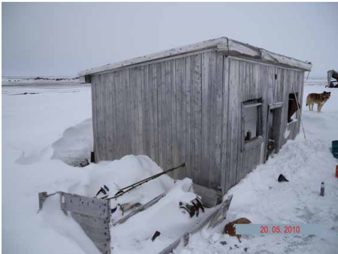
Фото 2.2.29 Склад конденсаторов и трансформаторов (объект № 164) на обследованном участке территории локационной станции
