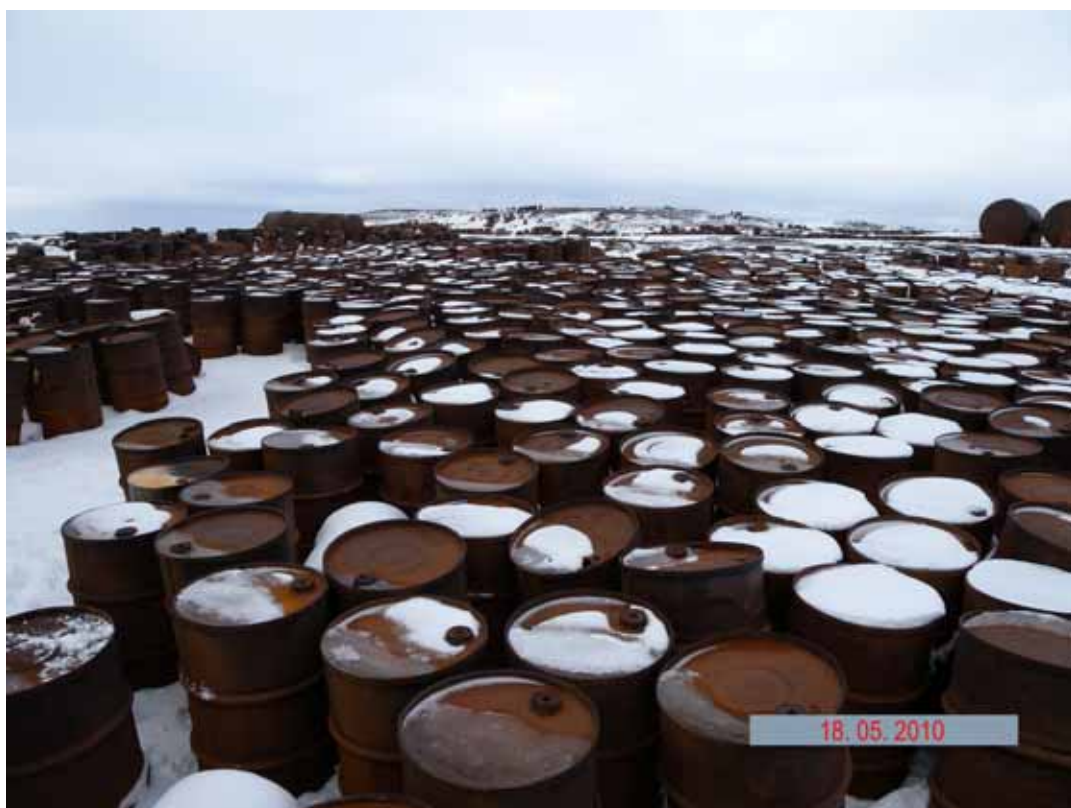
Фото 2.2.8 Штабель бочек на обследованном участке территории склада ГСМ в районе бухты Северная
