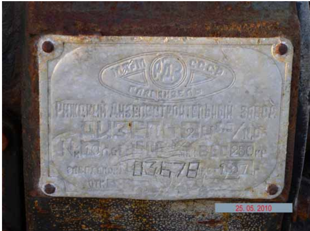
Фото 3.1.14 Дизель-электростанция на свалке оборудования РЛС на обследованном участке территории локаторной станции
