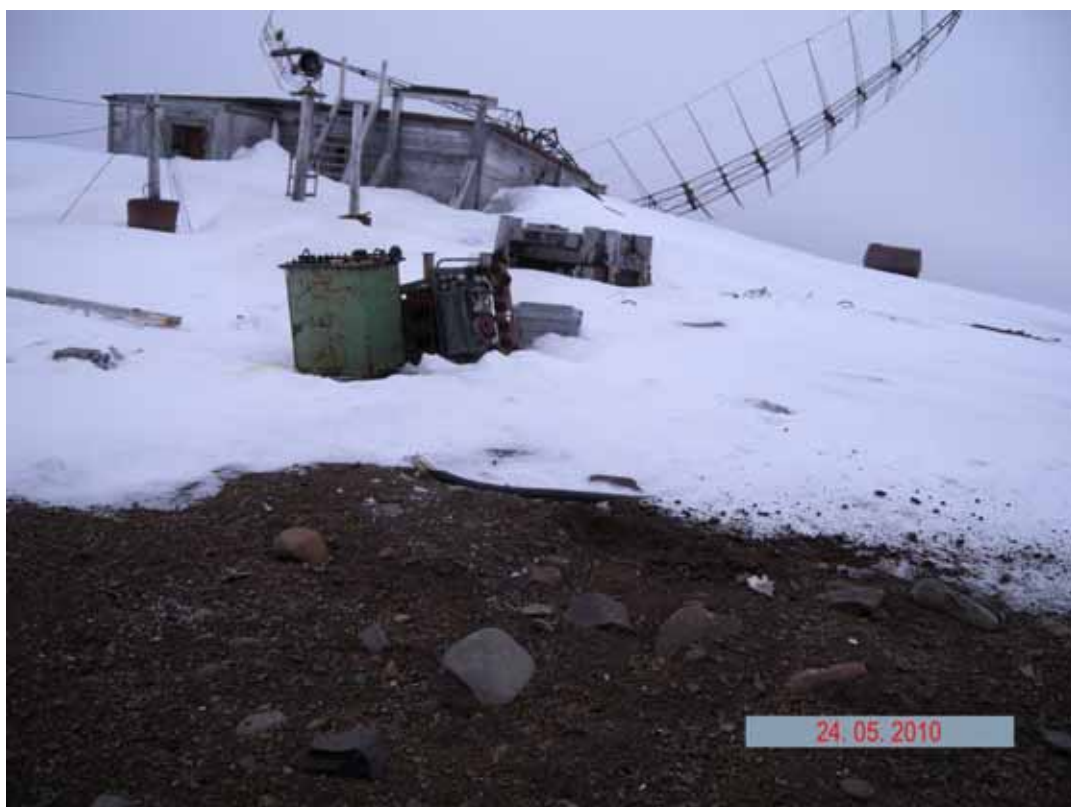
Фото 2.2.36 Трансформаторы, антенна и задние РЛС (объекты № 142, 145), на обследованном участке территории локаторной станции
