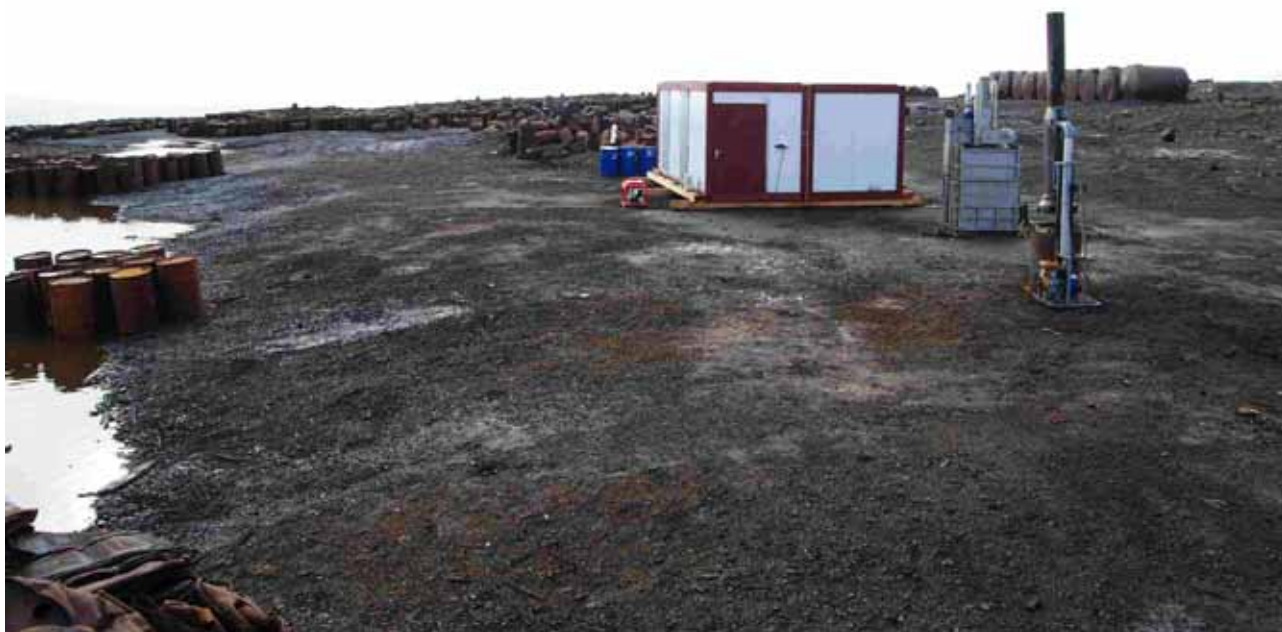
Рис. 13.4. Общий вид рабочей площадки
