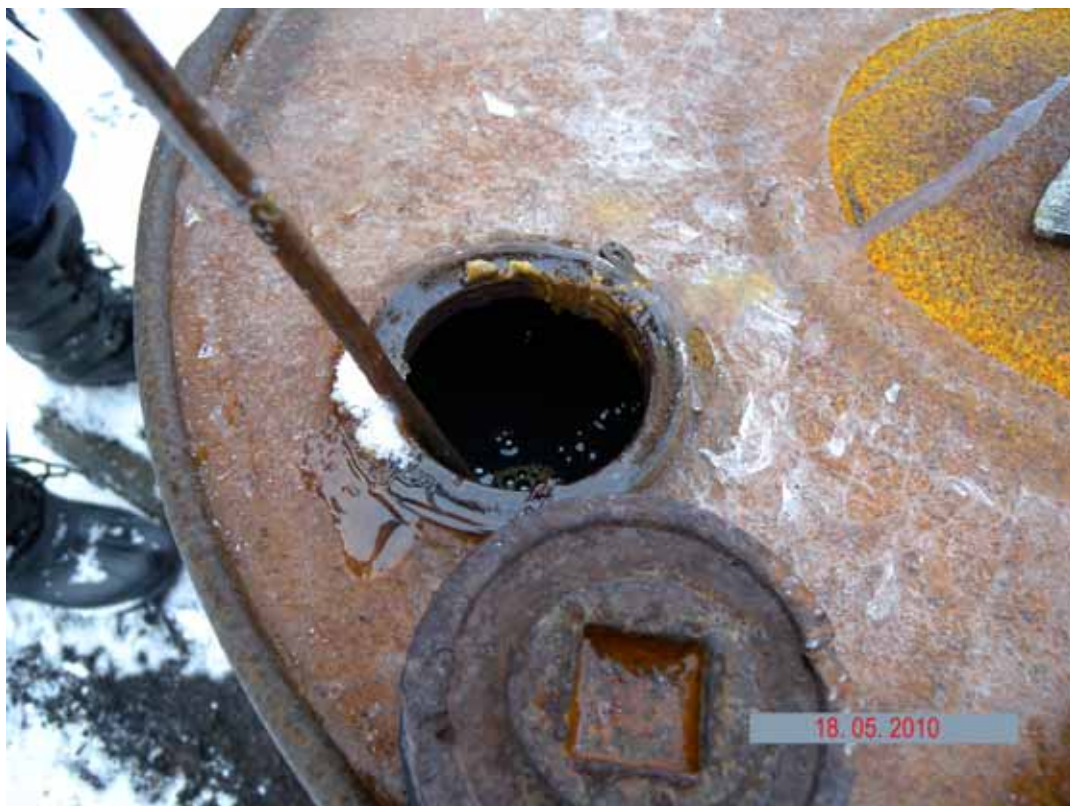
Фото 2.2.10 Бочка с нефтепродуктом на обследованном участке территории склада ГСМ в районе бухты Северная
