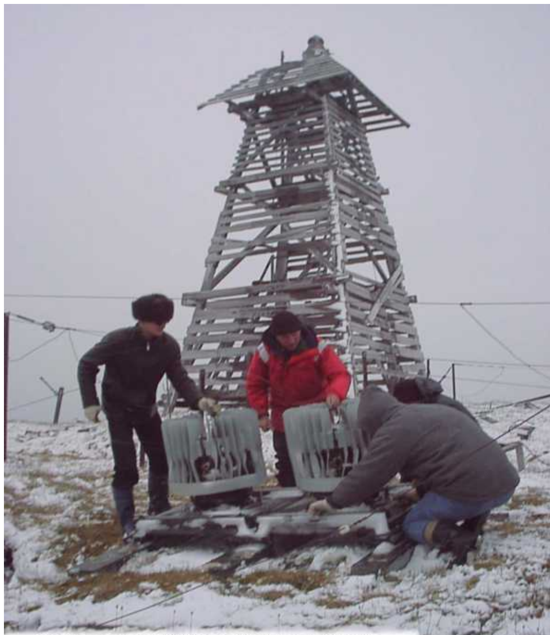
момент демонтажа РИТЭГов на СНО "Пакса", 21.08.05г. двумя представителями ВНИИТФА и двумя - Тикинской гидробазы
