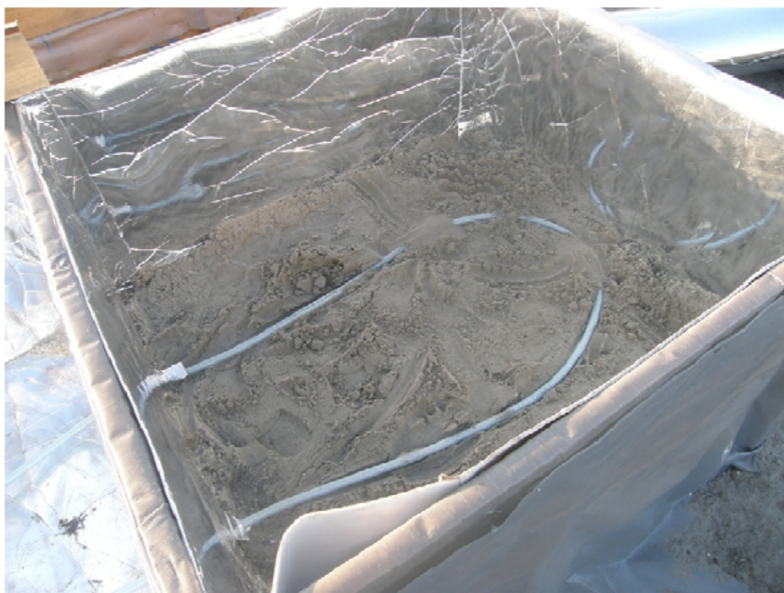
Рисунок 5г Система организации тепло и гидроизоляции ячеек в инженерной части полигона с укладкой сети перфорированных труб для аэрации почвы
