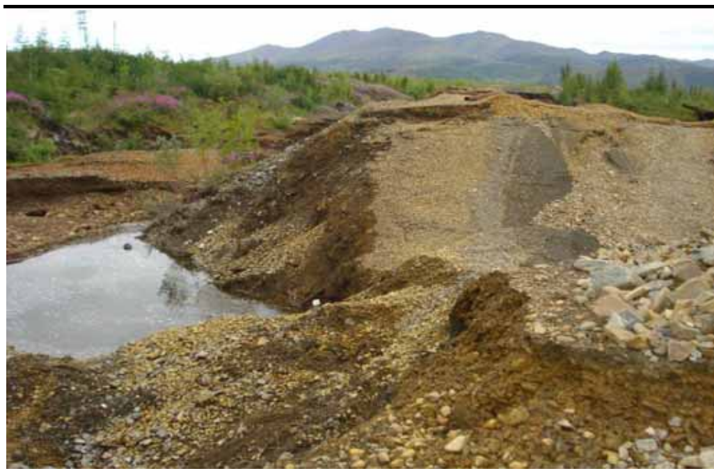
Фото 13 Участок подъездной дороги, просевшей в результате размыва. Фото 2
