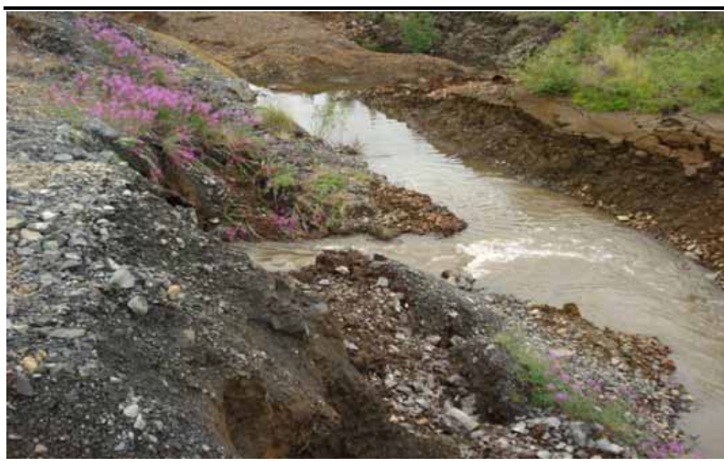
Фото 15 Место ухода руч. Поисковый под дорогу. На данном участке производилась простая отсыпка щебнем, укрепление откосов плотины бетонными плитами не проводилось.
