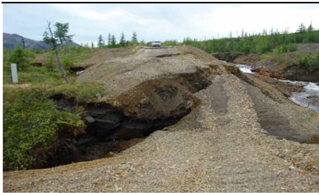
Фото 15 Место ухода руч. Поисковый под дорогу. На данном участке производилась простая отсыпка щебнем, укрепление откосов плотины бетонными плитами не проводилось.
