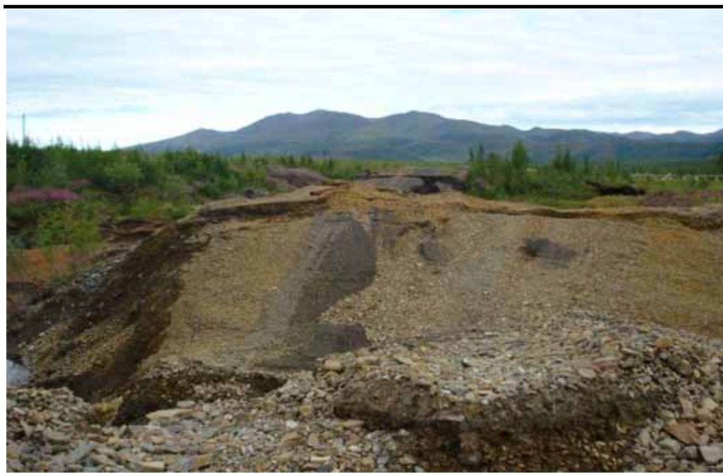
Фото 13 Участок подъездной дороги, просевшей в результате размыва. Фото 2
