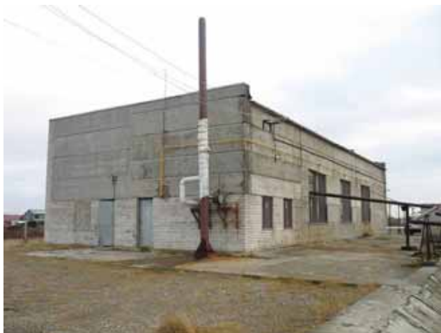
Фото 1. Здание КОС пос. Бондарный со стороны выпуска сточных вод
