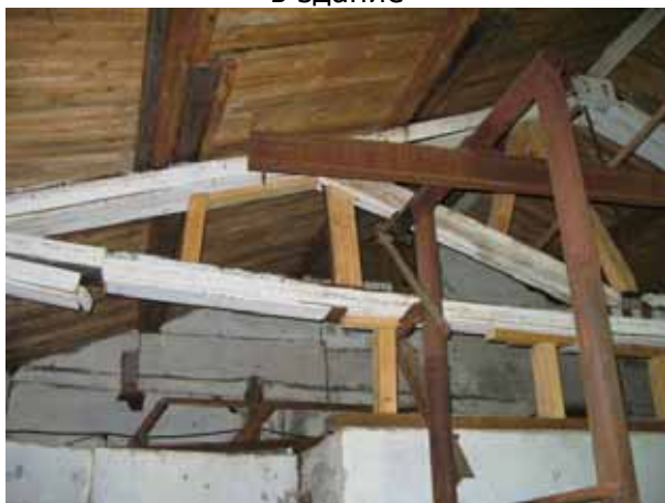
Фото 3. КОС пос. Качгорт, перекрытия
