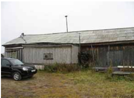
Фото. 1. КОС пос. Качгорт, со стороны входа в здание
