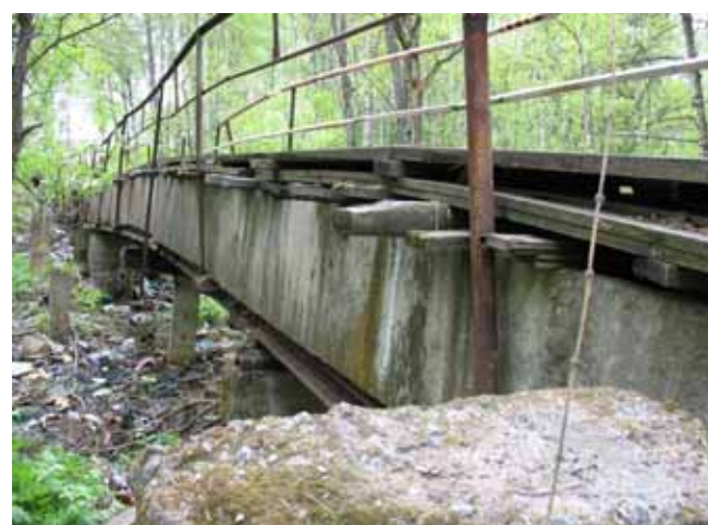
Фото 10. Эстакада на канализационной сети
