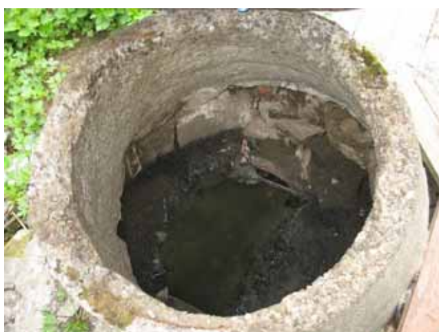
Фото 9. Канализационный колодец в верхней точке эстакады
