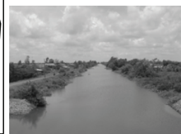
Kênh Xuyên Hòa Trạm bơm và cống kênh
