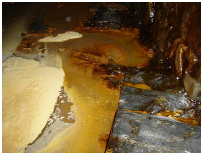
Figura 8 Filtración de Material Agresivo Procedente de Piritas y Deterioro de la Estructura del túnel por abundante lixiviación de piritas (Fuente: COMIBOL)
