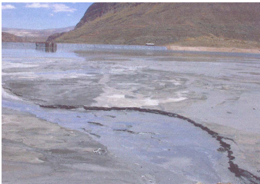
Figura 13 Ejemplo de un dique de cola: Dique de cola de Pampa grande (Fuente: Proyecto Pilcomayo)
