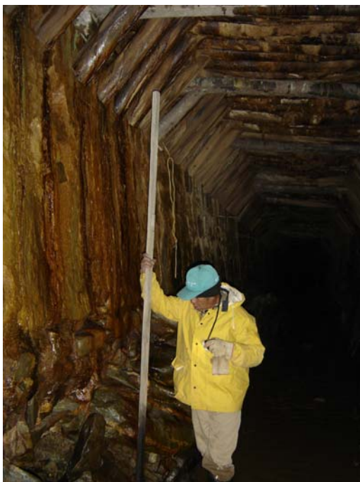
Figura 8 Filtración de Material Agresivo Procedente de Piritas y Deterioro de la Estructura del túnel por abundante lixiviación de piritas (Fuente: COMIBOL)
